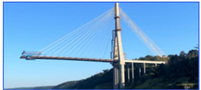
As pré-montagens das Aduelas Metálicas no canteiro de obras paraguaio continua em andamento com as unidades: 5.15 e 5.16. No Vão Central do tabuleiro continuam sendo executadas as armaduras dos guarda-rodas e bases do futuro guarda-corpo.
