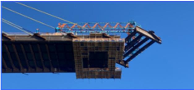
Em junho de 2022, as atividades em lado brasileiro se sucederam com o posicionamento das lajes pré-moldadas sobre a Aduela Metálica 6.15 já no vão livre da ponte, concretagem de interligação das mesmas sobre a unidade metálica, bem como o tensionamento do 15º par de estais em direção ao rio. Ainda no decorrente mês, ocorreu o lançamento da Aduela Metálica 6.16 no vão central da ponte para o processo de solda, bem como prevista a consolidação da laje que compõe a Aduela.
